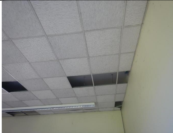
Abbildung 3: KMF-haltige Abhangdeckenplatten mit metallischer Unterkonstruktion (exemplarisch)
