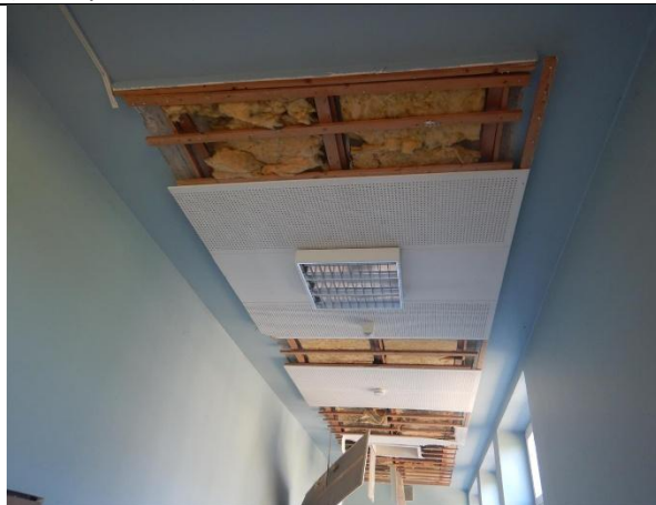
Abbildung 5: Abhangdecke Gipskartonplatten inkl. Holzunterkonstruktion und KMF-haltige Dämmung (exemplarisch)
