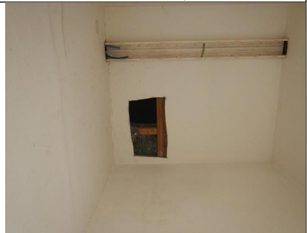
Abbildung 6: Abhangdecke Gipskartonplatten inkl. Holzunterkonstruktion und KMF-haltige Dämmung (exemplarisch)
