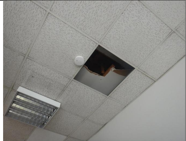
Abbildung 4: KMF-haltige Abhangdeckenplatten mit 2. Lage Gipskartonplatten inkl. Holzunterkonstruktion (exemplarisch)
