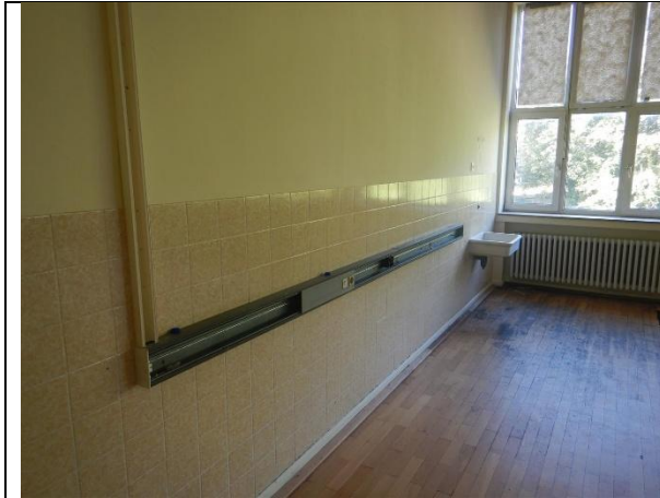
Abbildung 48: Kabelkanal (exemplarisch)
