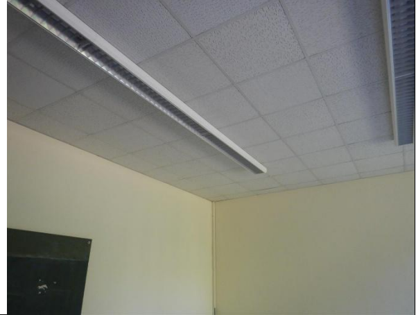
Abbildung 2: Abhangdecken mit Beleuchtung Raum (exemplarisch)
