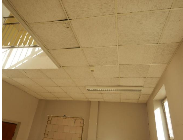
Abbildung 1: KMF-haltige Abhangdeckenplatten mit Beleuchtung Flur (exemplarisch)
